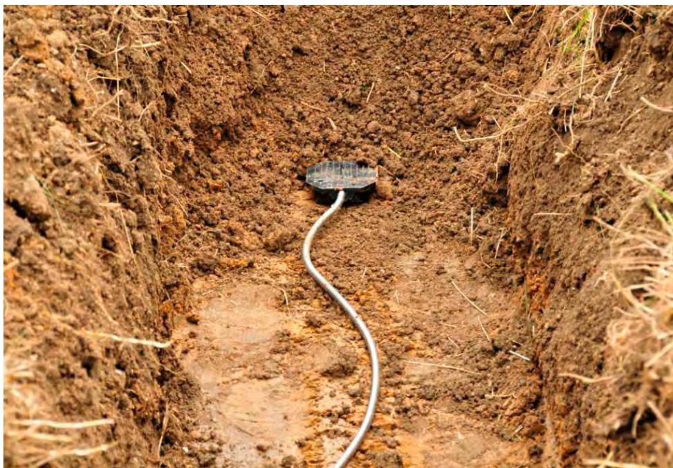
Рисунок 4. Покрытие поверхностным слоем грунта
