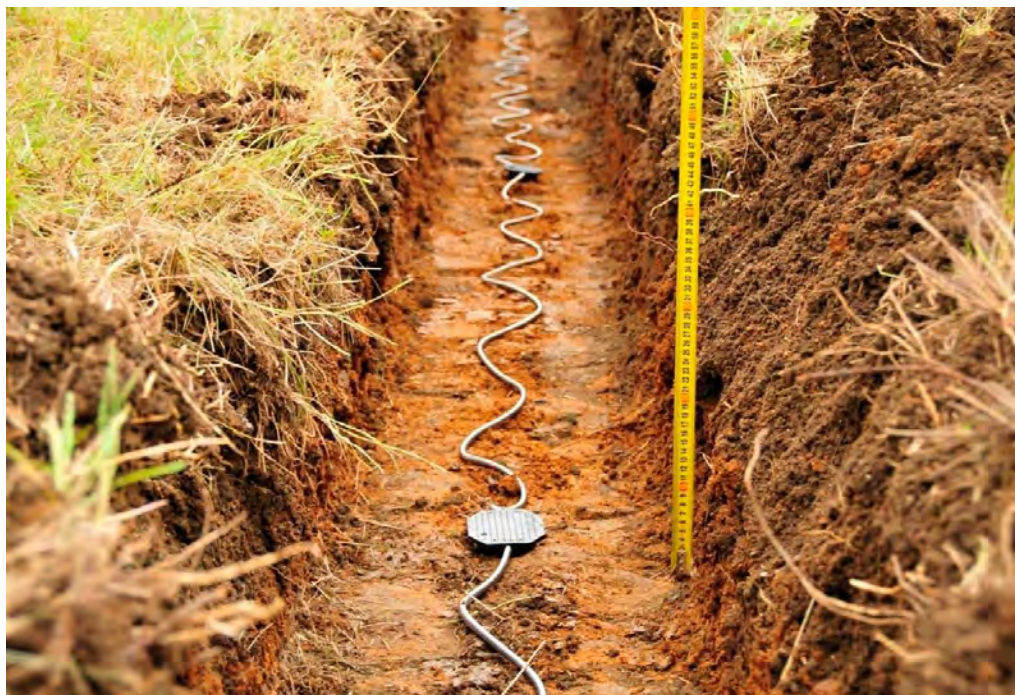
Рисунок 3. Установка детектора в грунт
