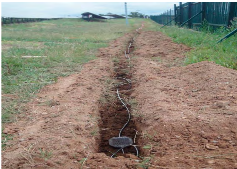
Рисунок 5. Пример установки датчиков
