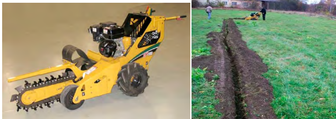
Рисунок 2. Подготовка траншеи
