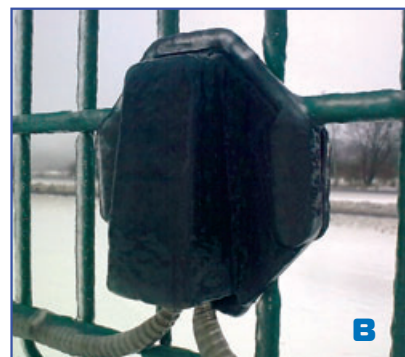
ДАТЧИКИ-ДЕТЕКТОРЫ СИСТЕМЫ PERIDECT: СТАНДАРТНЫЙ (А), СКРЫТНО УСТАНОВЛИВАЕМЫЙ (Б) И АНТИВАНДАЛЬНЫЙ (В)
